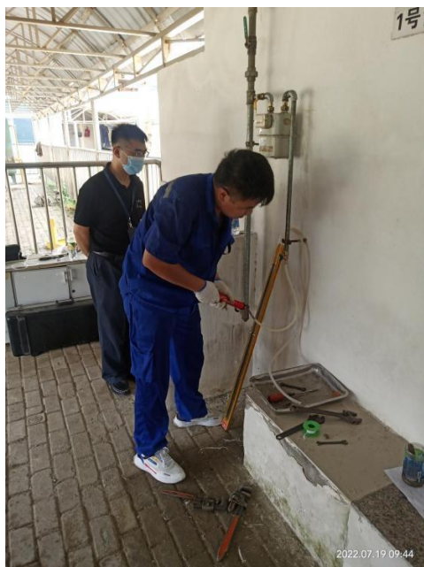
(武汉市天然气公司新员工岗位技能培训实训操练现场)
